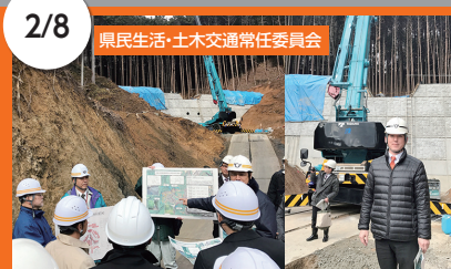
◆大津市若葉台急傾斜地崩壊対策事業現場 若葉台1地区急傾斜地崩壊対策工事の概要および進捗状況等についての調査
